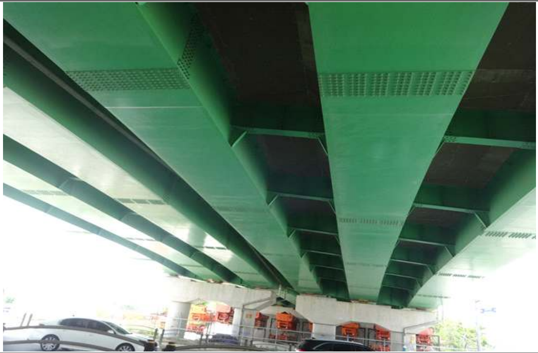
거더 및 바닥판하면 전경
