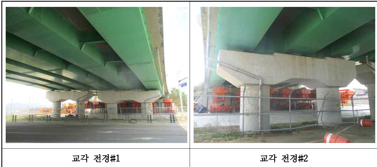
【사진 3.11】 교각 전경
