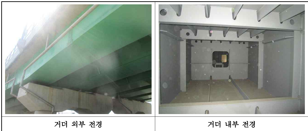
【사진 3.4】 거더 전경
