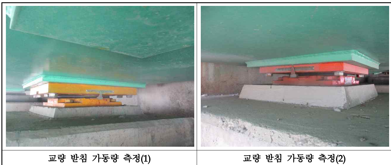
【사진 3.16】 교량받침 이동량 측정
