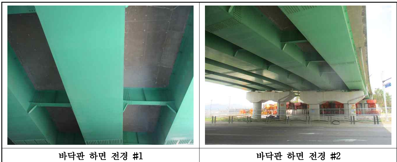
【사진 3.2】 바닥판 전경
